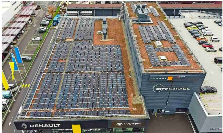
Die Photovoltaik-Anlage auf den Dächern des Autohauses soll rund 210'000 kWh Solarstrom pro Jahr generieren.
