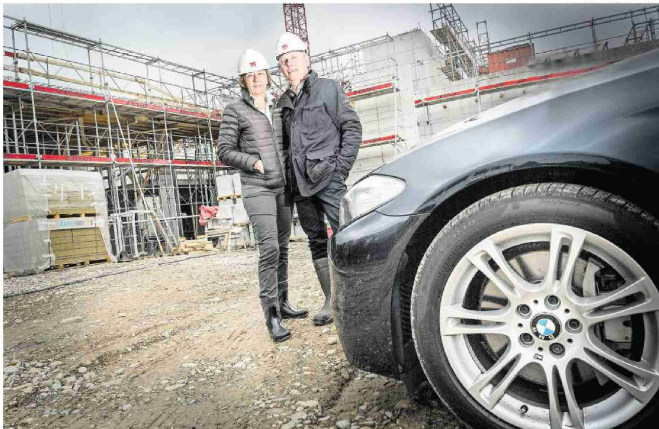
Beatrice und Andreas Bickel auf der Baustelle ihrer neuen Garage an der Dunantstrasse.
